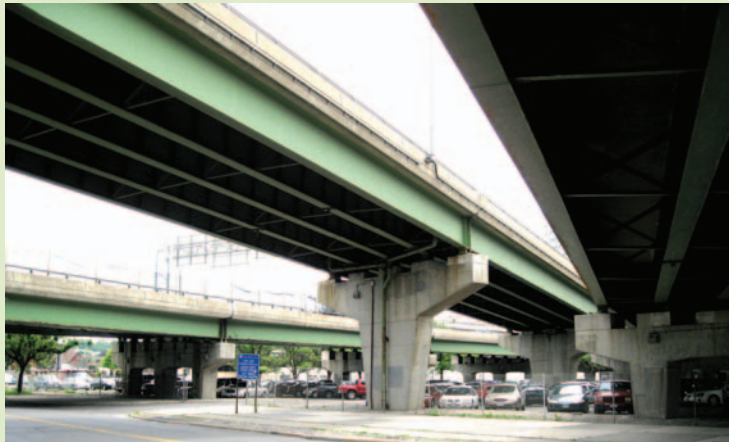
Los puentes del envejecido viaducto I-81 ya tienen, casi, 50 años.
